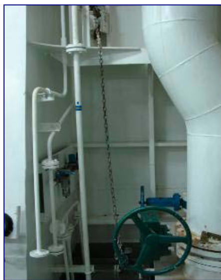
Foto 6: Detalhe do sistema de separação de água e óleo, com sua válvula de abertura lacrada.
